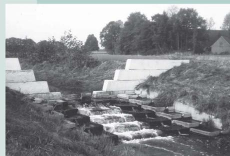
Gewässerbauliche Maßnahmen wie Begrädiungen, Kanalisierungen und das Einsetzen von Betonstufen in die Flüsse galten in den 60er und 70er Jahren als das Maß der Dinge um Hochwassern Herr zu werden. | Foto: H. Mollenhauer
