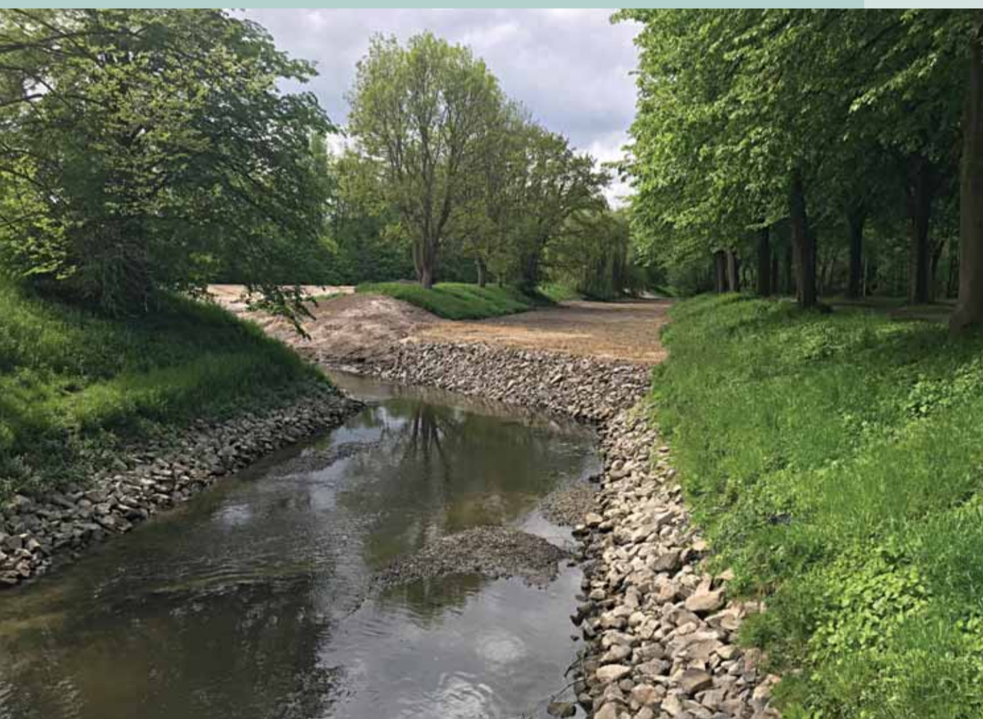
Die neu angelegte Überflutungsfläche ist hinten im Bild über dem ehemaligen Flussbett zu erkennen. | Foto: E. Oberhaus
