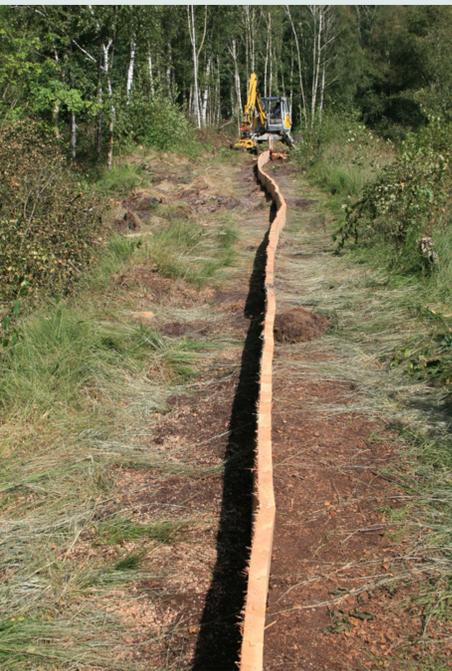
Spundwände aus Holz wurden zur Unterstützung der Wasserspeicherung im Moor eingebaut. | Foto: Kerstin Wittjen
