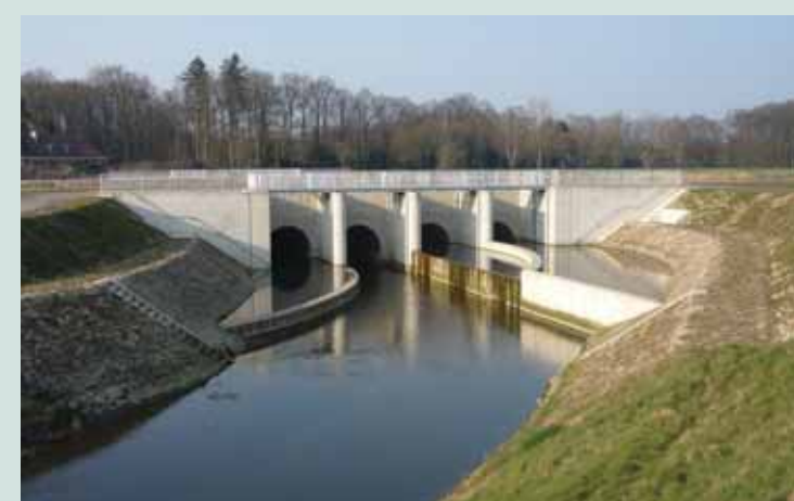
Weiter flussaufwärts leitet in Senden ein „Düker“ die Stever unter den Kanal hindurch. Dort muss das Wasser durch eine Druckleitung Höhenunterschiede überwinden, während es hier am „Durchlass“ mit einem freien Wasserspiegel den Kanal kreuzt. Foto: Hermann Mollenhauer
