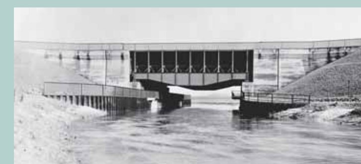
Auch für die "Neuen Fahrt" wurde eine Kanalbrücke über die Stever geplant und umgesetzt. | Foto (1949): Historisches Bildarchiv der Bundesanstalt für Wasserbau
