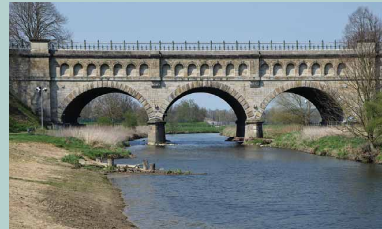
Beim ersten Bau der Wasserkreuzung in Olfen führte die Dreibogenbrücke den Kanal in der "Alten Fahrt" über die Stever. Sie beeindruckt noch heute mit ihrer Bauweise und ist ein beliebter Aussichtspunkt mit Blick auf die Steverau geworden. | Foto: Sandra Dirks
